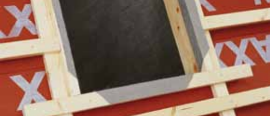
Устройство проёма мансардного окна
