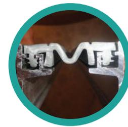
Закладные конструкции деформационных швов ДШ-П на высоту 15, 25, 35 и 50 мм, прямые и угловые
